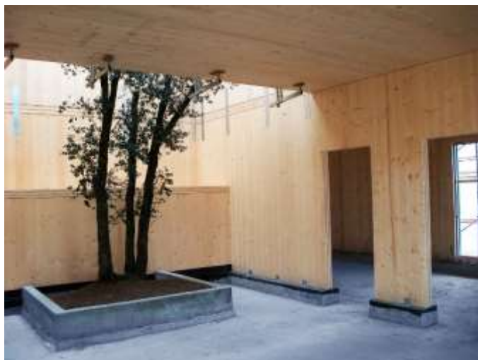
Fig. 8 – Posa delle pareti su costolature delle fondazioni.
