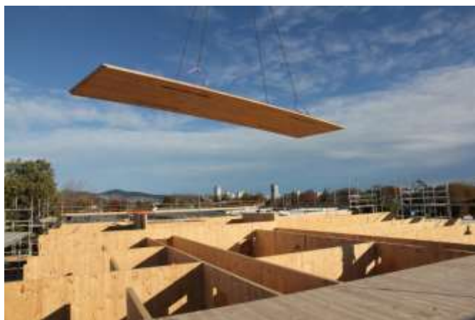
Figure 3 e 4 Movimentazione in cantiere di pannelli in XLAM
