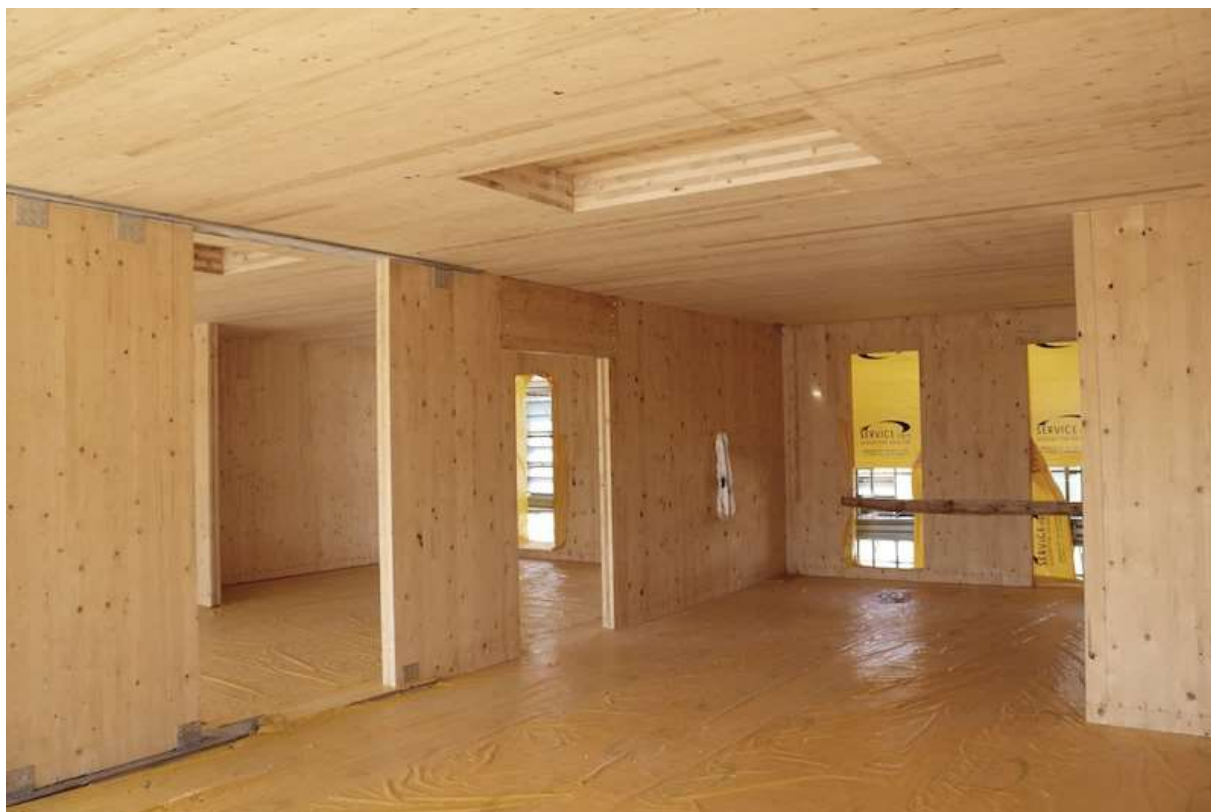
Fig. 14 vista interna struttura XLAM
