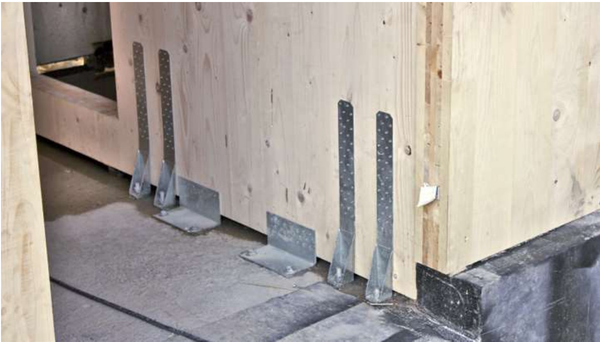
Fig. 11 sistemi di connessione di tipo "hold-down" e "a taglio"
