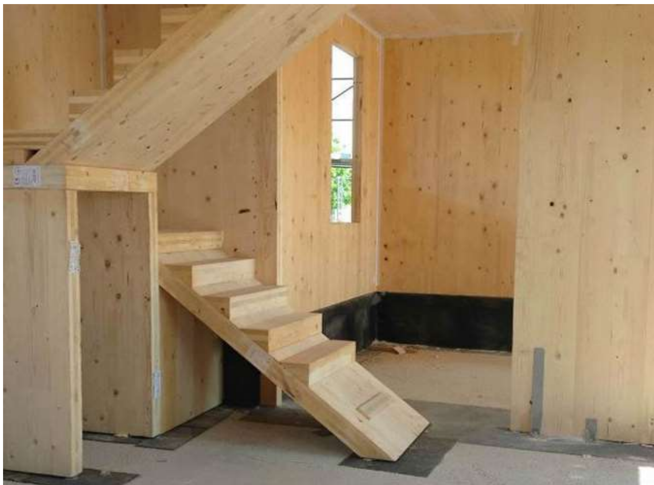
Fig. 16 – esempio di scale in pannelli di XLAM
